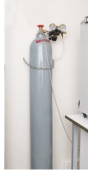
Şekil Sıkıştırılmış gaz içeren tüplerin duvara sabitlenmesi
